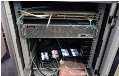
2Uサイズの高性能メインフレーム「Kairos Core1000」をオンサイトに設置
